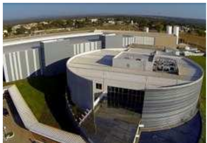
Complexo Datacenter Cidade Digital Fotografia: Jornal da CAIXA , 2014.
