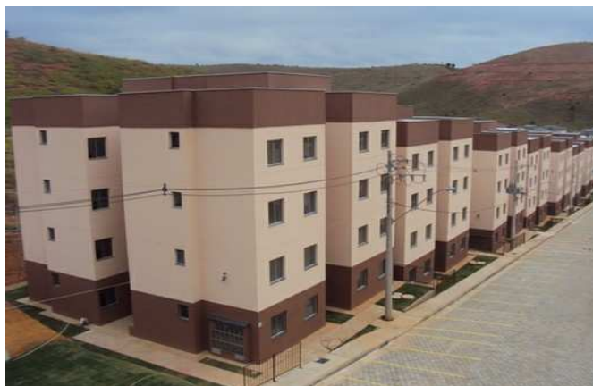
Residencial Sertão do Rio Doce I, empreendimento do MCMV em Governador Valadares/MG
