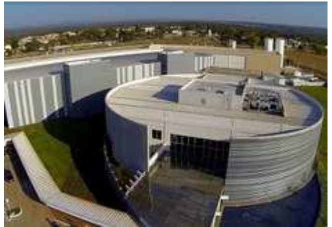
Complexo Datacenter Cidade Digital Fotografia: Jornal da CAIXA, 2014.
