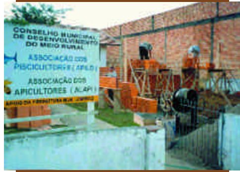
Obras APILO e ALAPI
