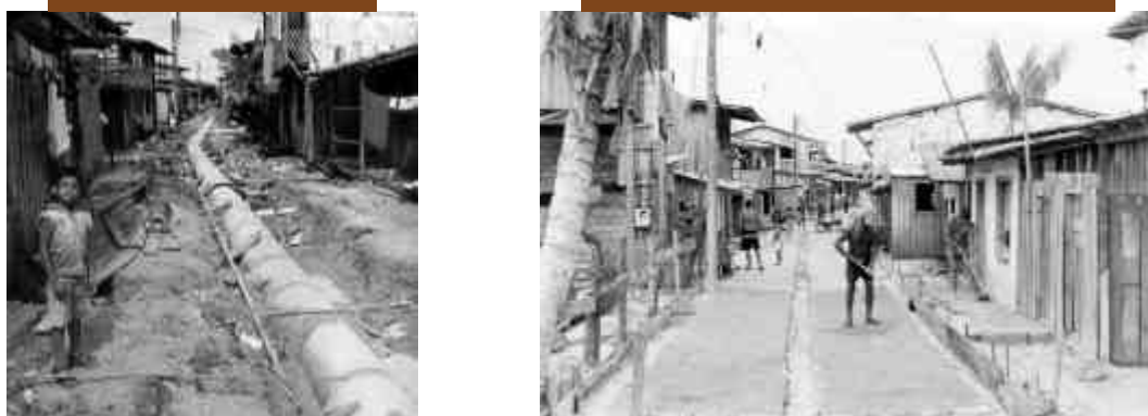
Fotos 18 e 19: Implantação da rede de drenagem na área do Tucunduba (2001).
