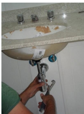
Figura 7.14: Instalação de louças e metais (serviço com tempos úteis e ociosos)
