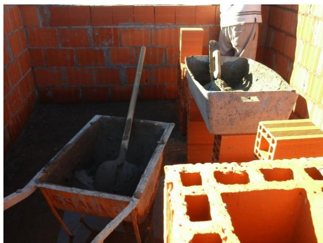
Figura 7.15: Apropriação Direta do Consumo Real da Argamassa em Assentamento de Blocos
