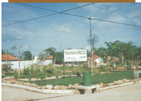
Parque Ambiental sobre galeria de drenagem Vila Santa Rita (zona Sul)
