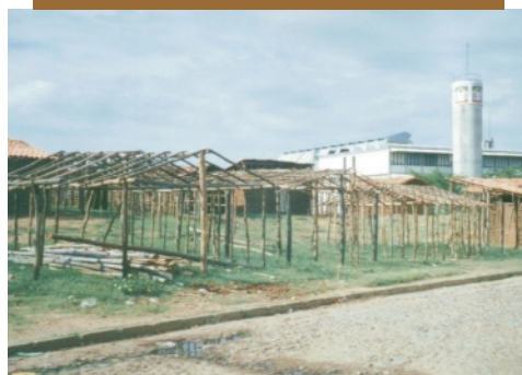
Nova ocupação em área situada próxima à Vila Ciac (zona Sul)
