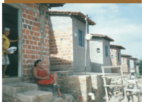
Melhoria habitacional em fase de conclusão Vila Nova (zona Sul)
