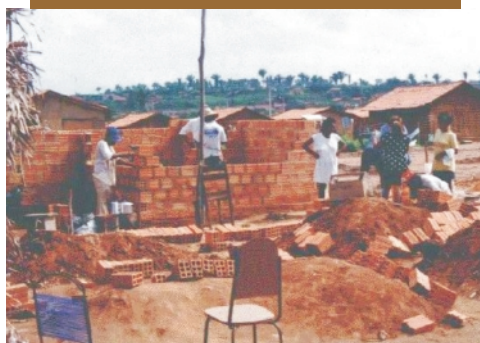
Construção de unidades habitacionais
