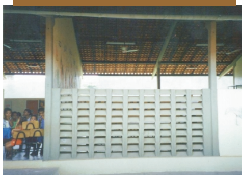
Interior da Creche (iluminação e ventilação natural) Residencial Betinho (zona Sul)
