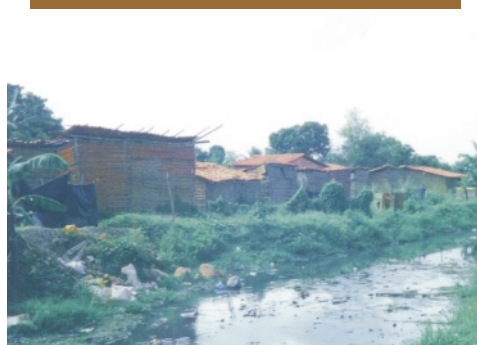
Ocupação irregular em área situada atrás da Vila Carlos Feitosa (zona Norte)
