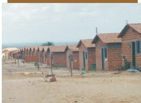
Construção de unidades habitacionais
