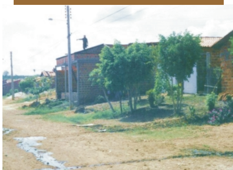
Construção de unidade habitacional e arborização)Residencial Betinho (zona Sul)
